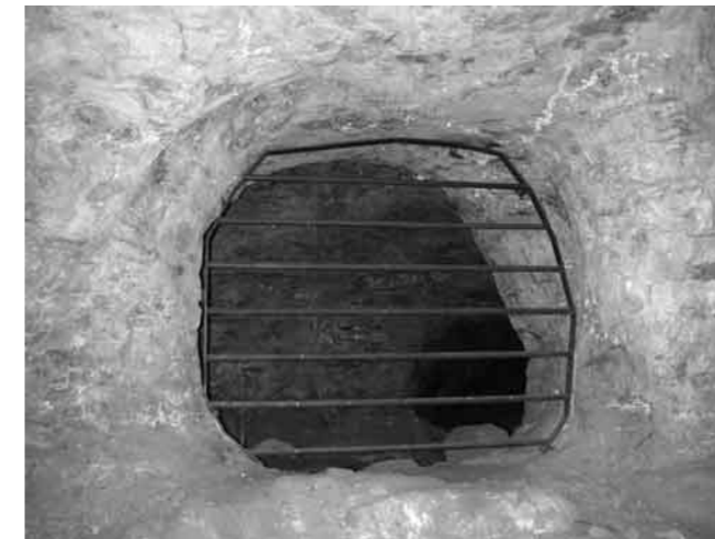
Un exemple de protection apportée par l'APPB : une grille disposée dans les Carrières de Loubeau
