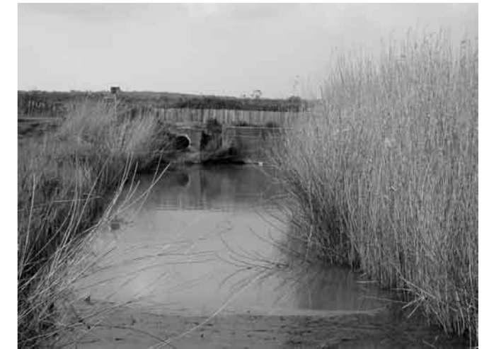
Pont avec passage à loutres au-dessus d'un canal à Saint-Denis du Payré (Vendée)
