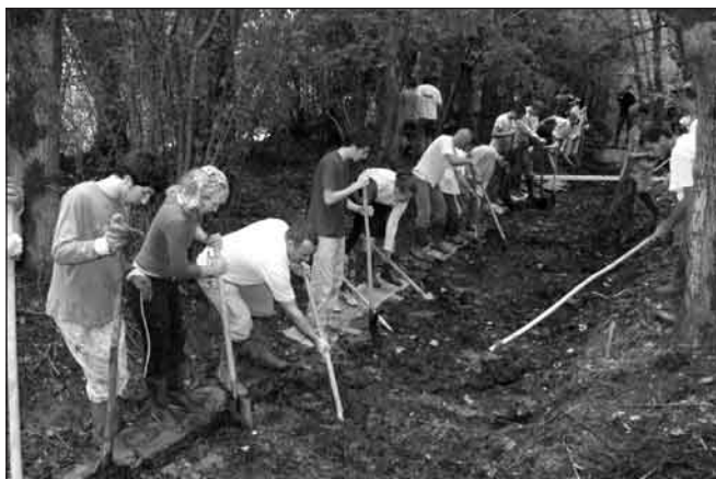
Chantier de curage du 15 août.
