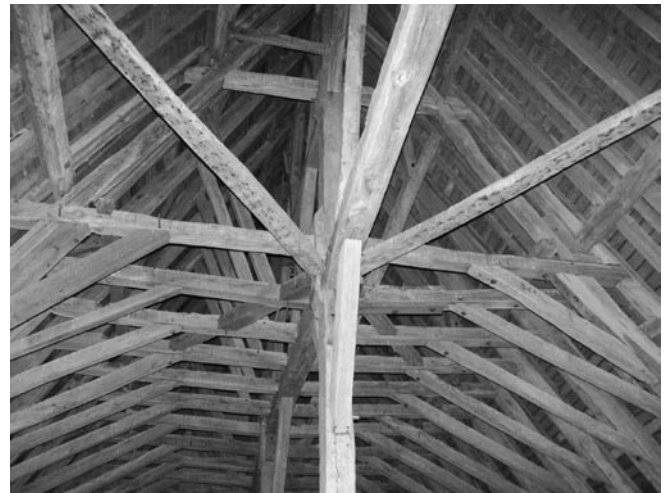
Charpente de l'église de Oiron. Photo : Sandrine Bracco.
